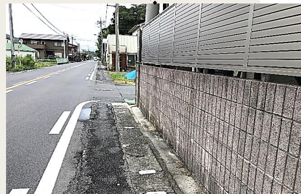
ガードレール無い狭い歩道、車と接触の恐れ
